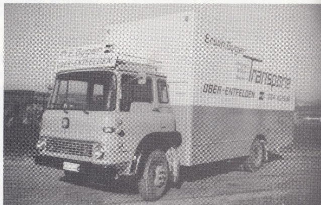
Der erste Transportwagen auf der noch im Bau befindlichen Suhrentalstrasse
