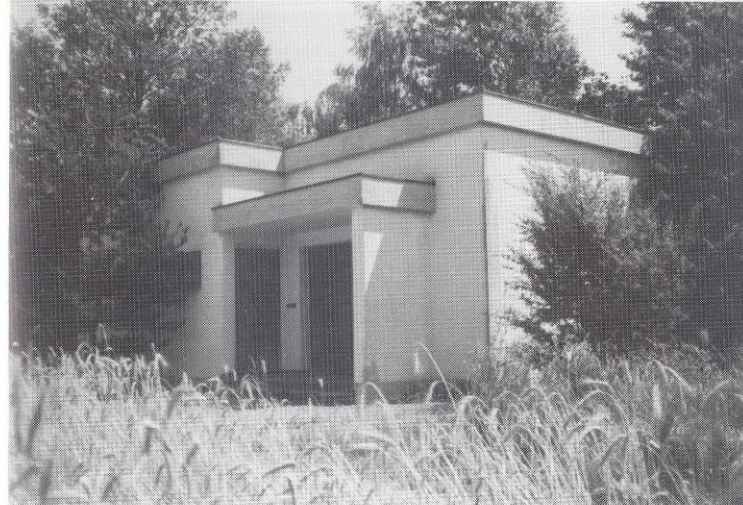
Seit 20 Jahren wird mit dem Grundwasserpumpwerk Tanngassmatten der weitaus grösste Teil von Oberentfelden mit Wasser versorgt
