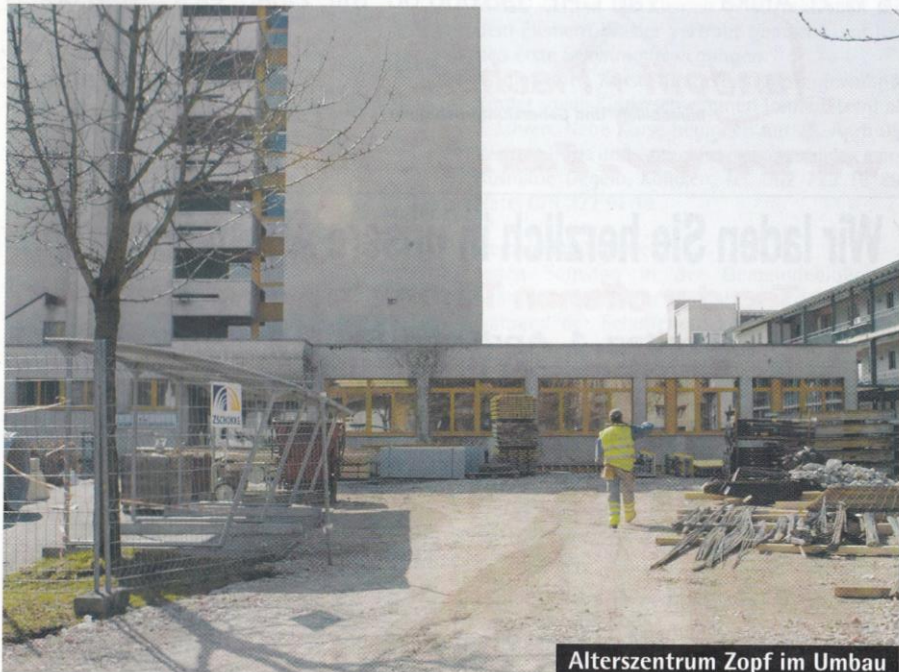
Alterszentrum Zopf im Umbau
