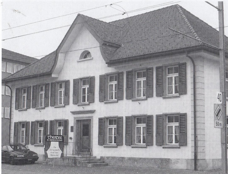
Das erste wirklich geräumige Schulhaus im Unterdorf kostete anno 1832 nur 6000 Franken
