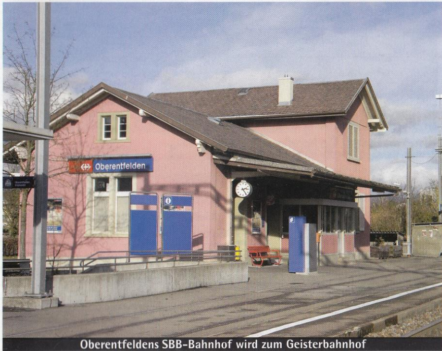
Oberentfeldens SBB-Bahnhof wird zum Geisterbahnhof
