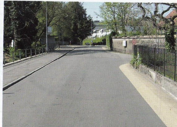
Seitenmarkierung zur Einengung der Fahrbahn
