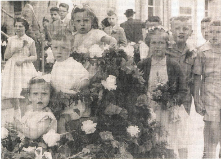
Entfelder Schulhauseinweihung anno 1956
