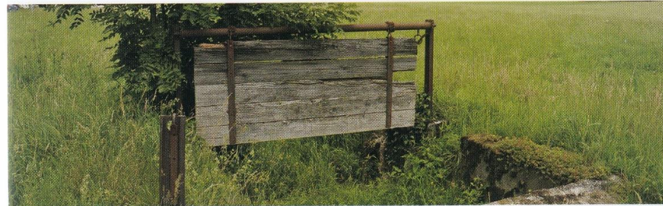
Mit einem Wuhr wurde das Wasser gestoppt und auf die Wiese geleitet
