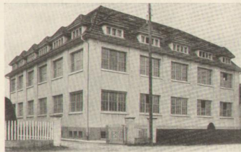
Neubau des Jahres 1916, in welchem ein Teil des stark angewachsenen Maschinenparkes untergebracht wurde
