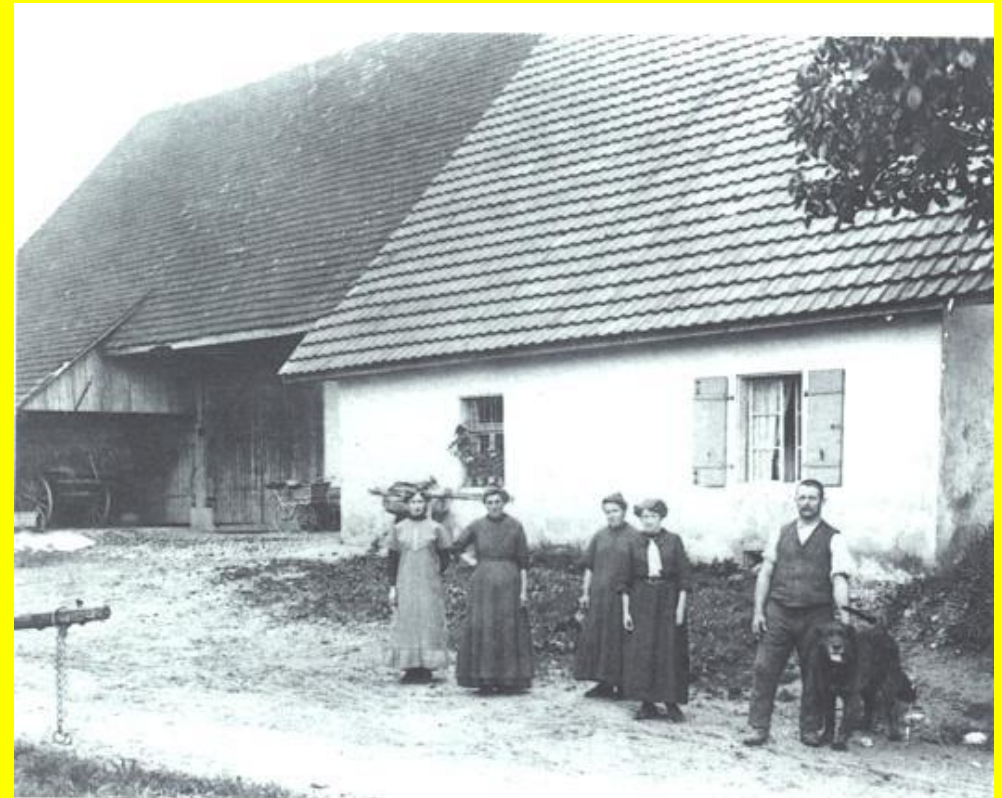
Haus Frey im Behmen, abgebrochen 1983.
