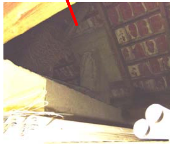
Oberhalb der des Hühnerstalls
