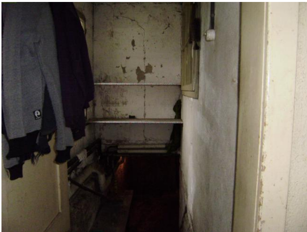
Abbildung 8 Treppe in den Keller, Rechts Fenster zur Küche
