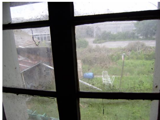
Abbildung 30 Fenster nach Norden 3
