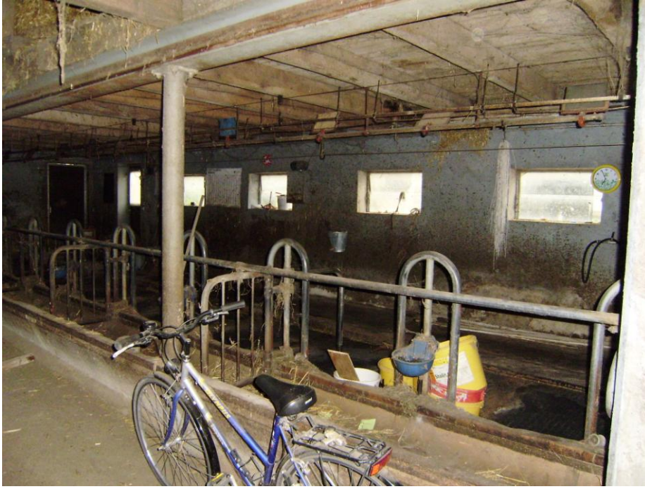
Abbildung 44 Grosser Stall. Fenster nach Westen
