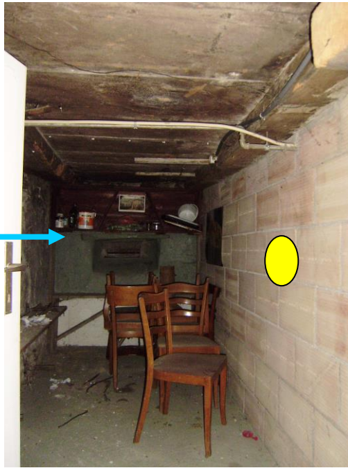
Schlitze zur Lüftung / Hochwasser
