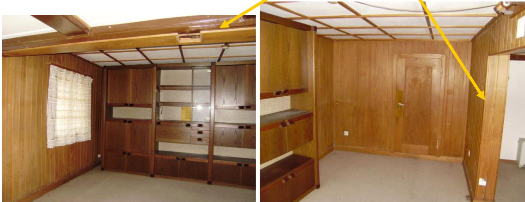
Dieser Raum ist am 22.8.08 bereits abgerissen.
