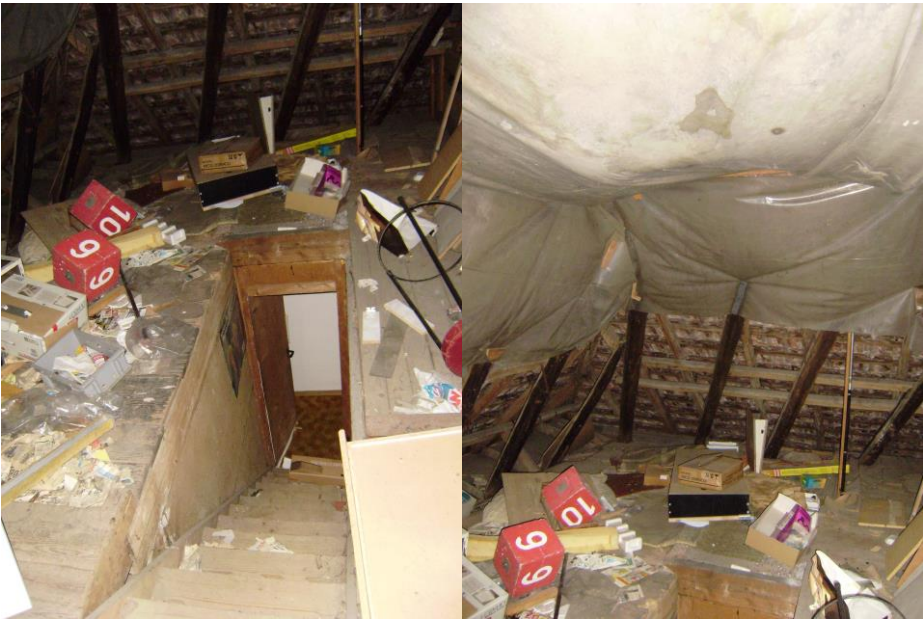
Treppe zum Estrich
