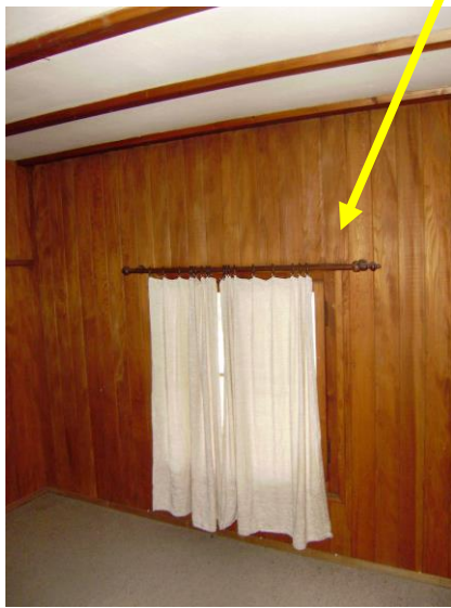
Fenster liegen sehr tief
