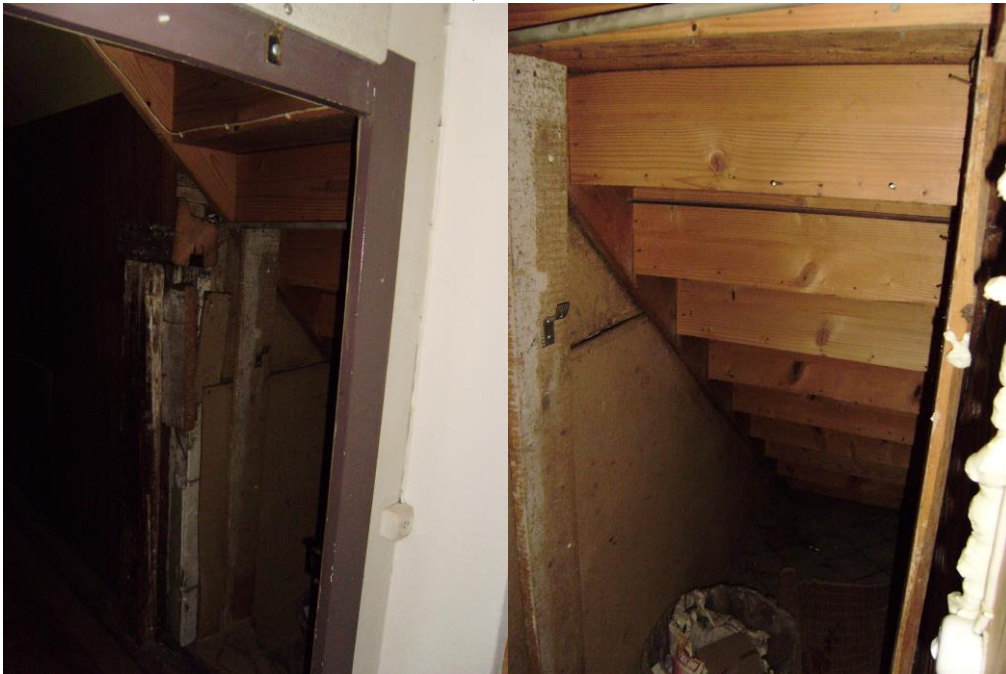
Raum hinter der Treppen / Fenster vermacht
