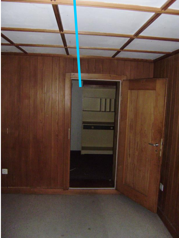
Kleiner Abstellraum (fensterlos)
