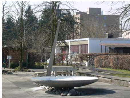
Abb. 65 Siedlung Sprecher & Schuh
