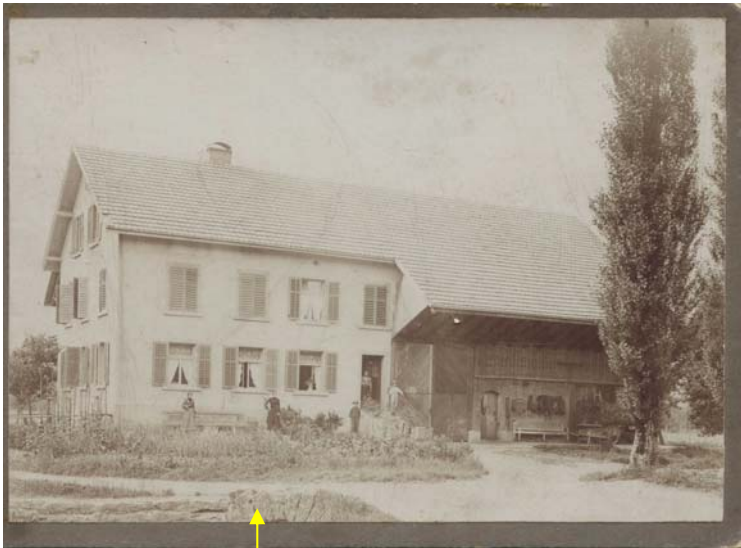
Abb. 34 Grabenunterführung Isegüetlistrasse 50 um 1900
