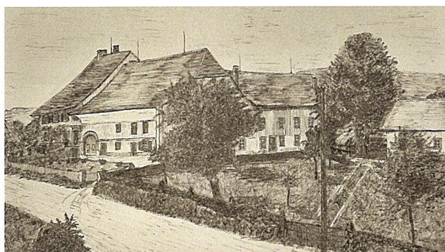
094 Ansicht vor 1900, bevor die neuen Fabrikationsräume 1902 erstellt wurden.
