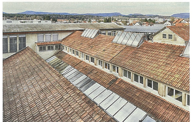
115 Aussenansicht der ehemaligen Pecherei Q101
