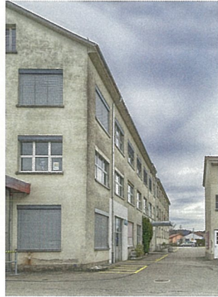
098 Gebäude A2. Aufnahme Widmer 2018.
