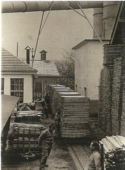
128 Der Holzplatz. Hinten rechts der Silo. Q113
