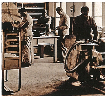
137 Celluloidbearbeitung im 1. Stock des Gebäudes B (1919-ca. 1945) Q118a/92
