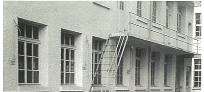
142 Aussentreppe Haus B2. Q126
