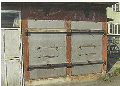
129 Trockenräume. Diese Räume stehen 2018 noch, sind aber von innen nicht mehr interessant. Q114
