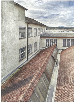
097 Blick auf die Stanzei. Aufnahme Widmer 2018
