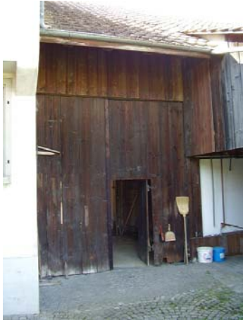
Von Osten Links WC Anbau
