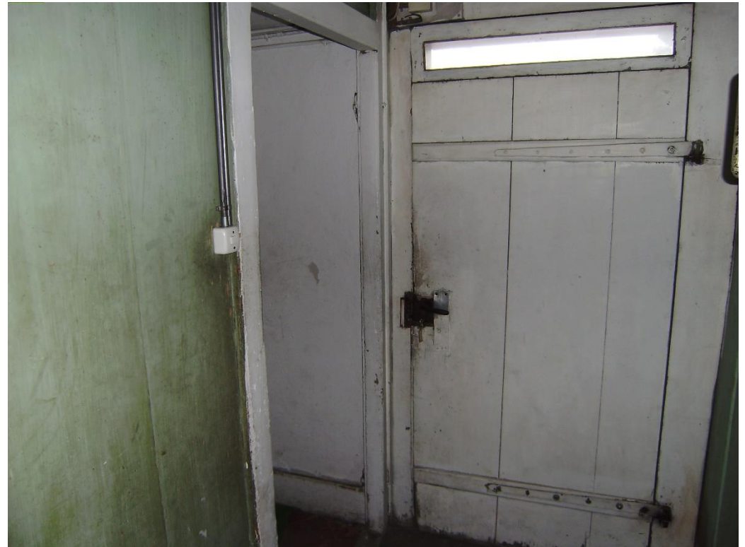
Haupteingang Links Treppenhaus und Küche
