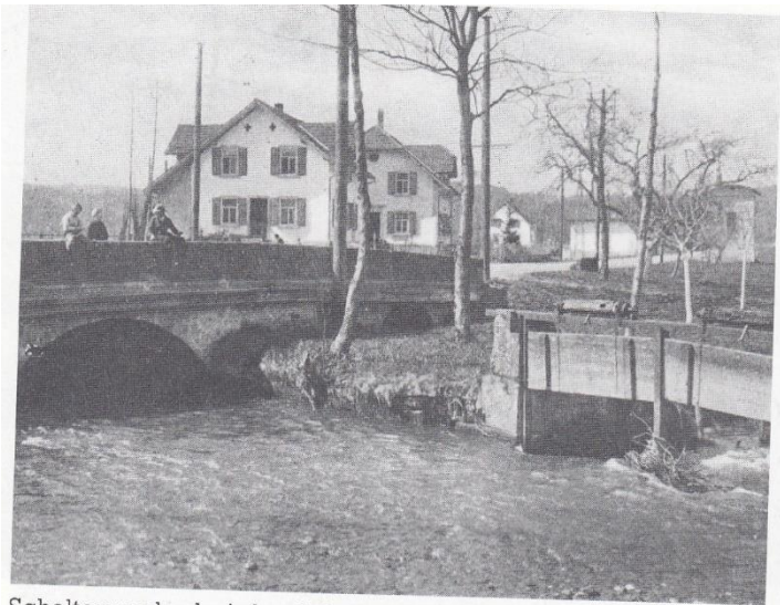
Schaltenwerke bei der Suhrenbühel...
