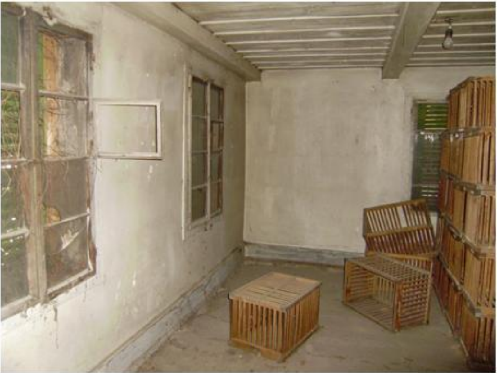
1. Durchgangszimmer oben an der Küche
