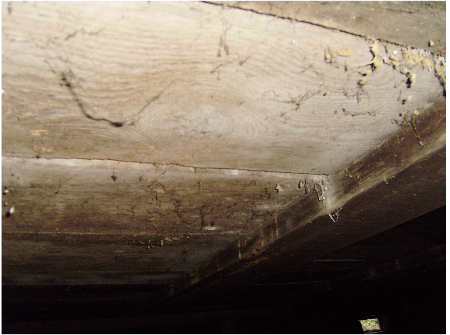
Trämkellerdecke im Keller
