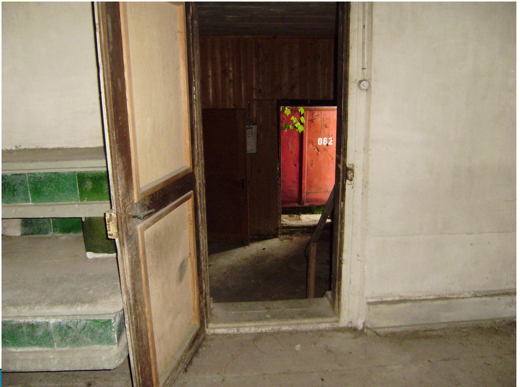
1. Durchgangszimmer Blick zum Eingang (Container)
