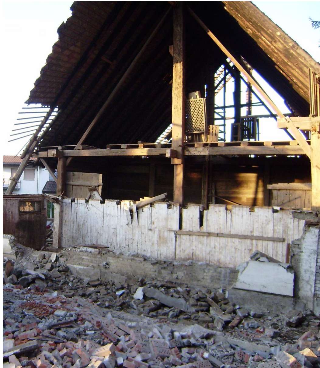
Haus im Abbruch
