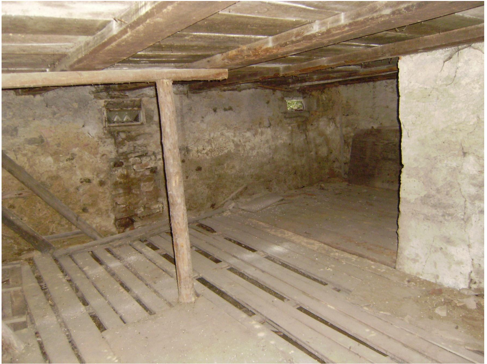
Keller unter dem Wohnbereich
