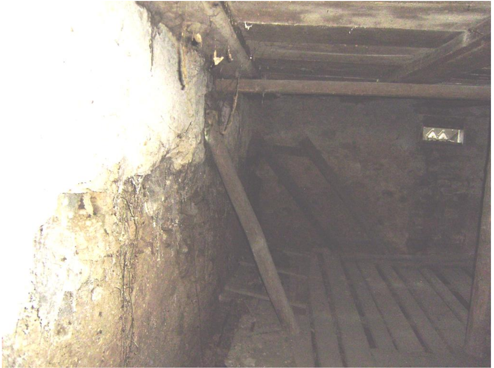
Keller unter dem Wohnbereich
