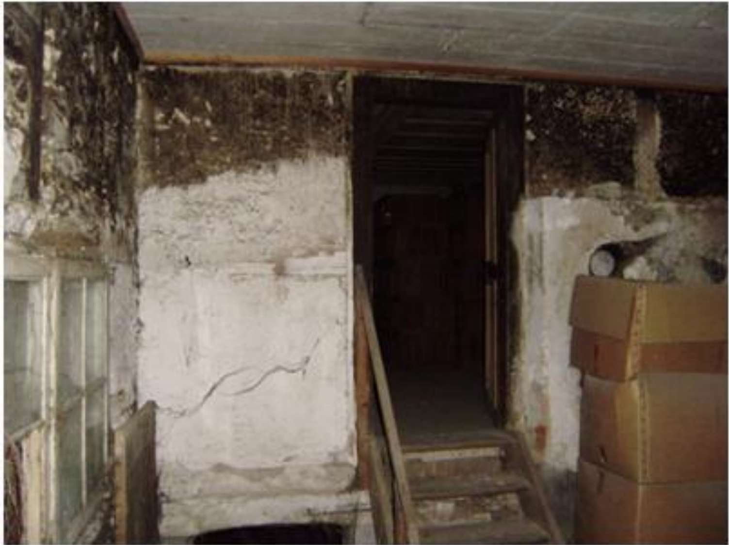
Treppe in die Durchgangszimmer
