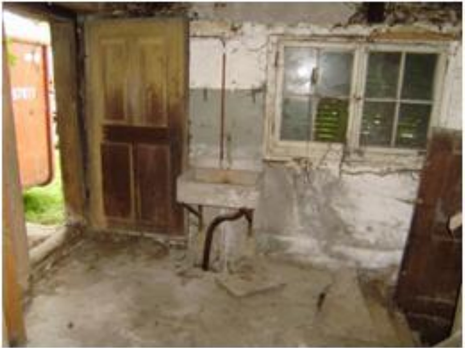
Eingang zum Wohnteil
