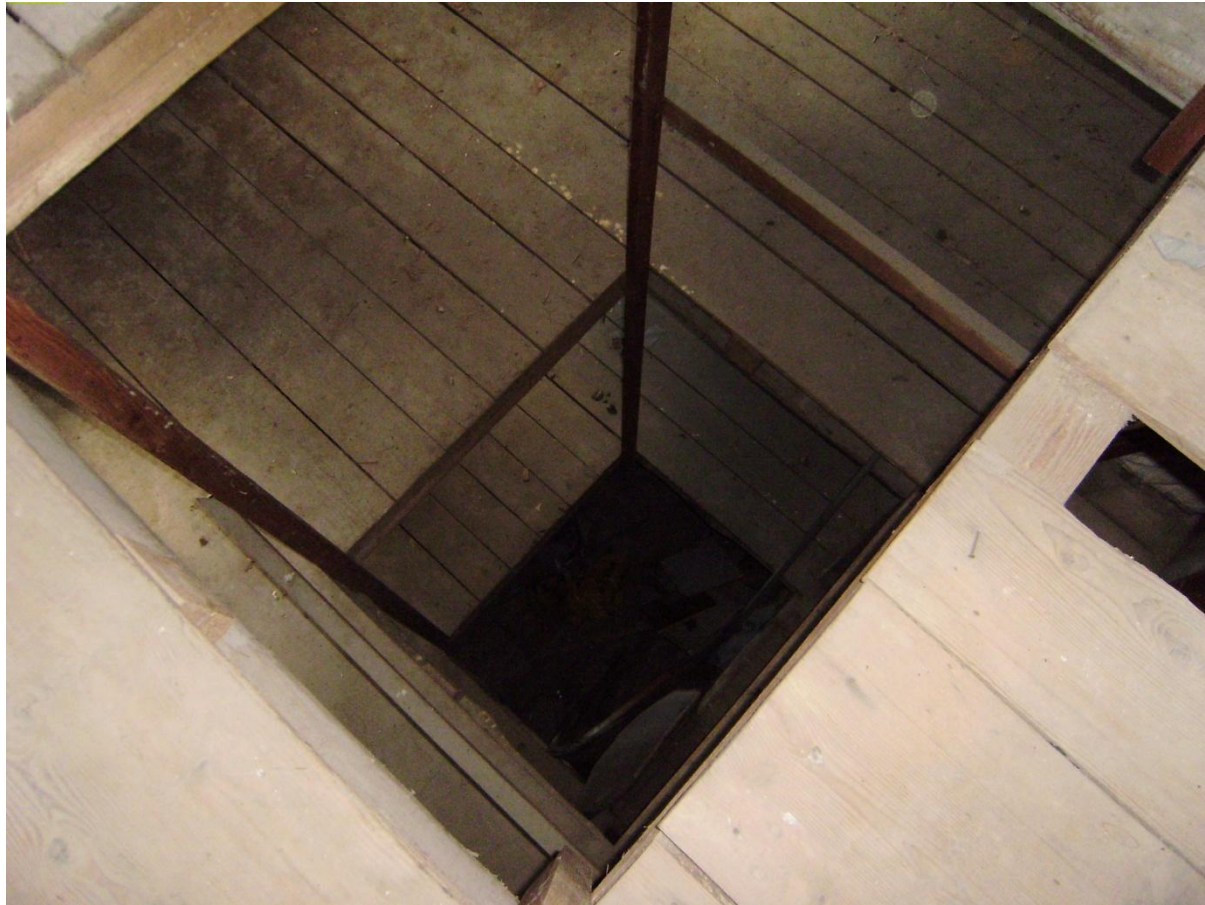
Blick durch den Aufzug
