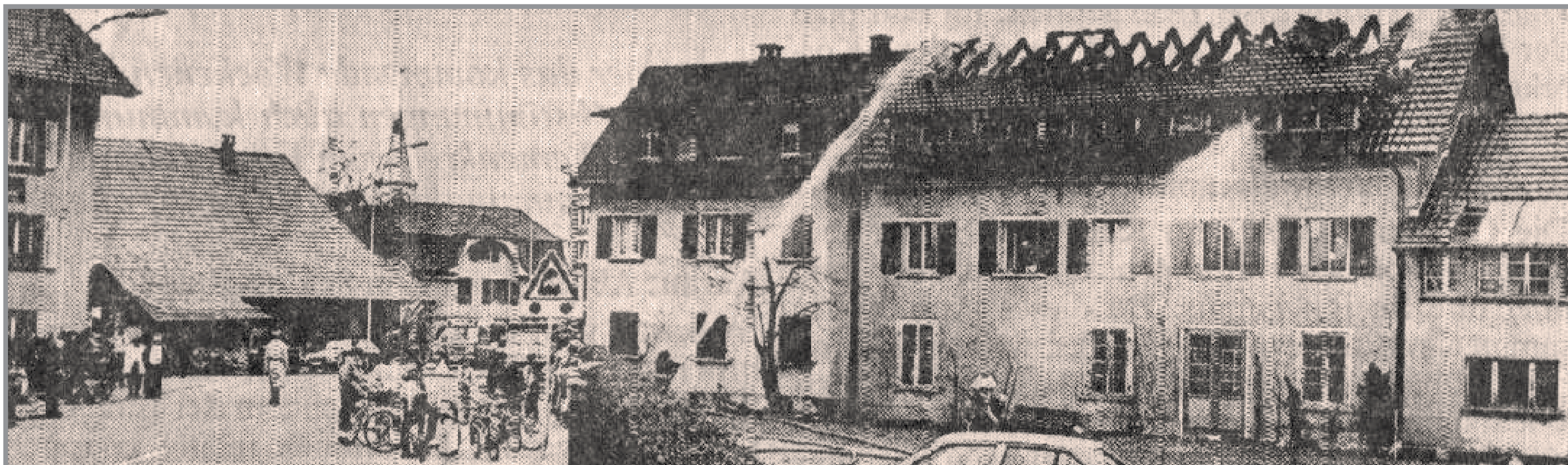
7.3.1985: Aus dem Text: „In dem sich vor etwa 50 Jahren das Restaurant Insel befand.“ „Der Dachstock des Hafner-Hauses brannte fast vollständig aus.“
