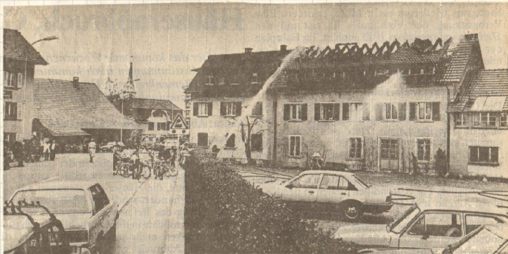
Dachstock ausgebrannt: Die Strasse war mehrere Stunden gesperrt.
