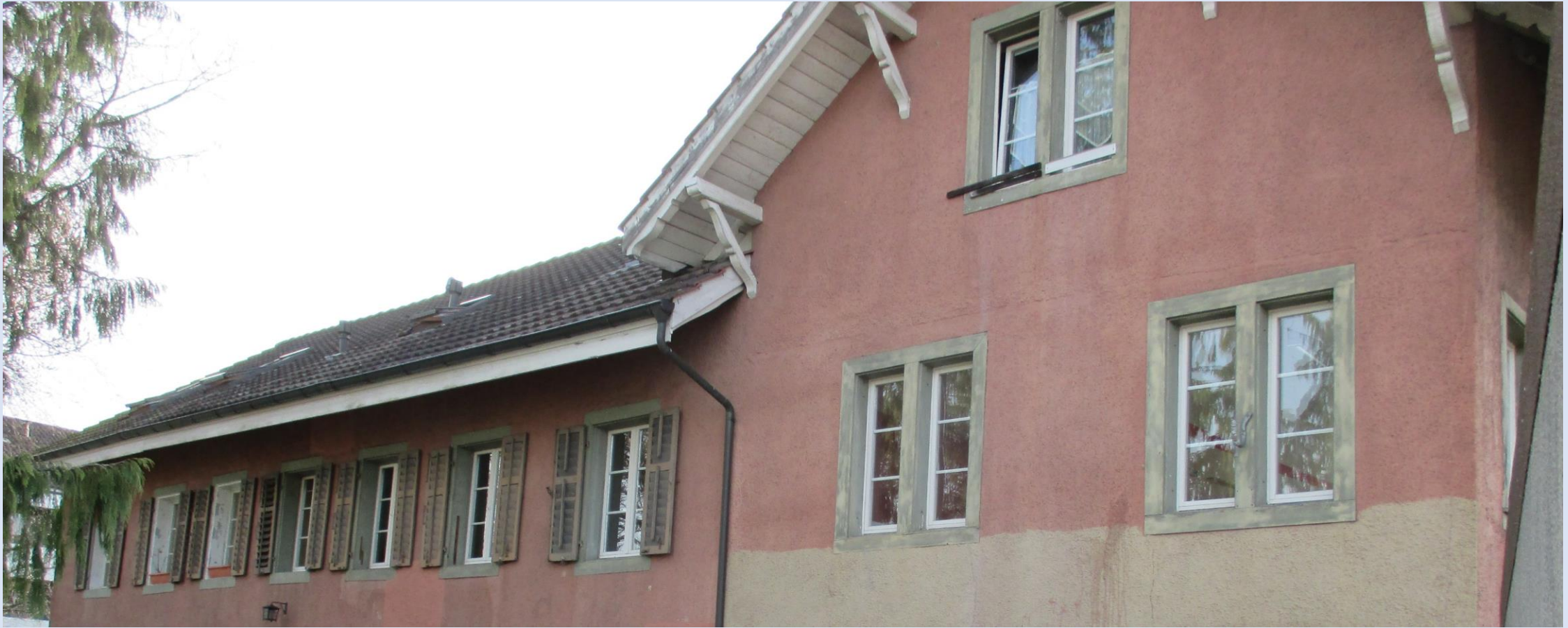
Dachgeschoss von Osten
